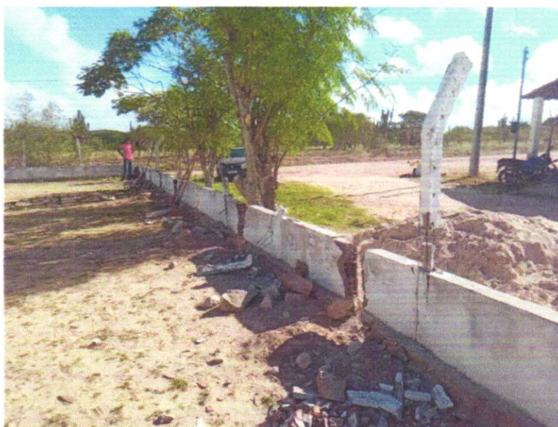
FOTO 11 - DEMOLIÇÃO DE ALVENARIA DE BLOCO FURADO, DE FORMA MANUAL, SEM REAPROVEITAMENTO. AF_09/2023
