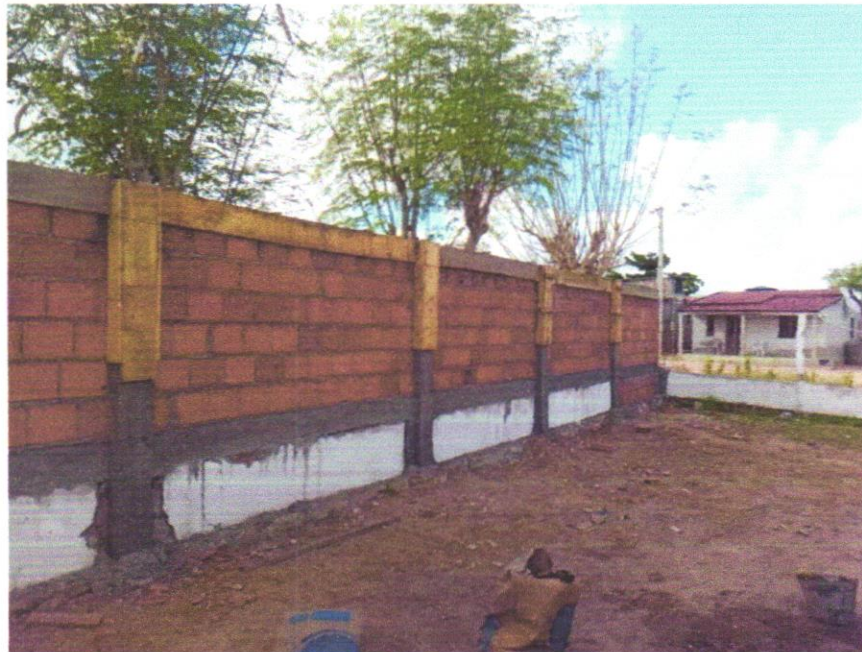
FOTO 07 - FABRICAÇÃO DE FÔRMA PARA PILARES E ESTRUTURAS SIMILARES, EM CHAPA DE MADEIRA COMPENSADA PLASTIFICADA, E = 18 MM. AF_09/2020
