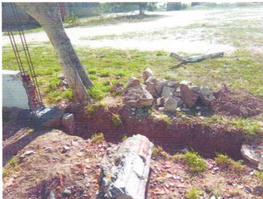
FOTO 11 - DEMOLIÇÃO DE ALVENARIA DE BLOCO FURADO, DE FORMA MANUAL, SEM REAPROVEITAMENTO. AF_09/2023
